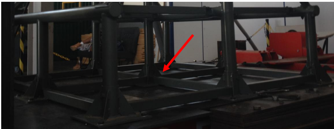
Figura 38 – Detalhe da sapata central que não recebeu nenhum parafuso.
