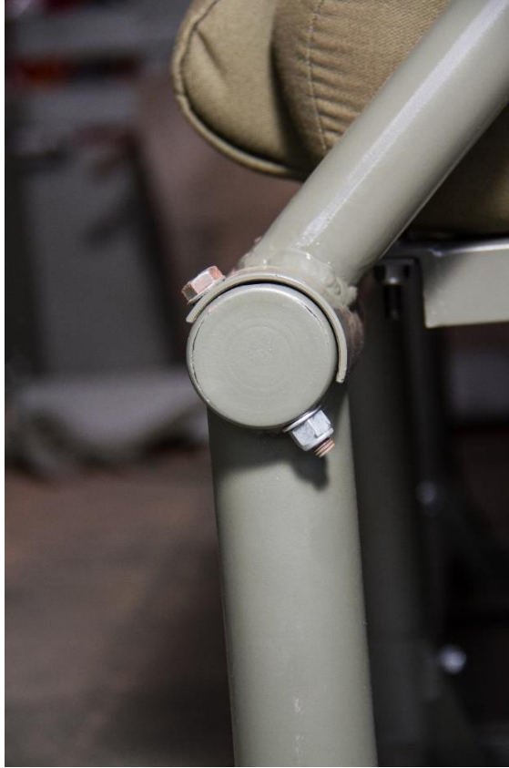
Figura 24 – Detalhe fixação inferior reforço lateral.
