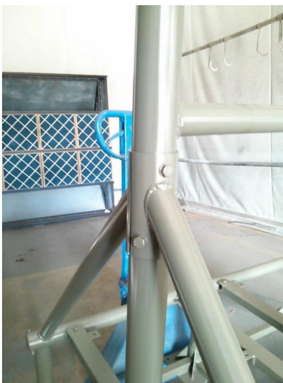
Figura 23 – Detalhe fixação superior reforço lateral.
