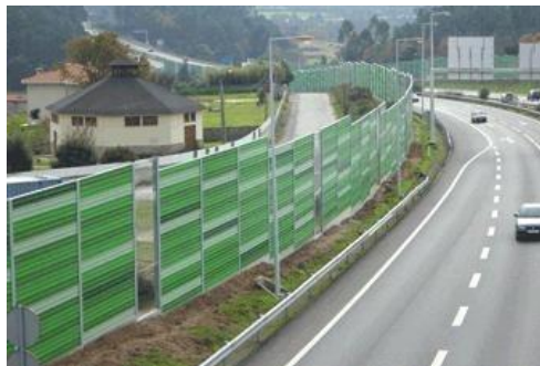
Figura 2 - Barreira acústica em rodovia (Disponível em: http://www.lnz.com.br/arquivosSGC/SERV20090703073007barreira_acust.JPG ).
