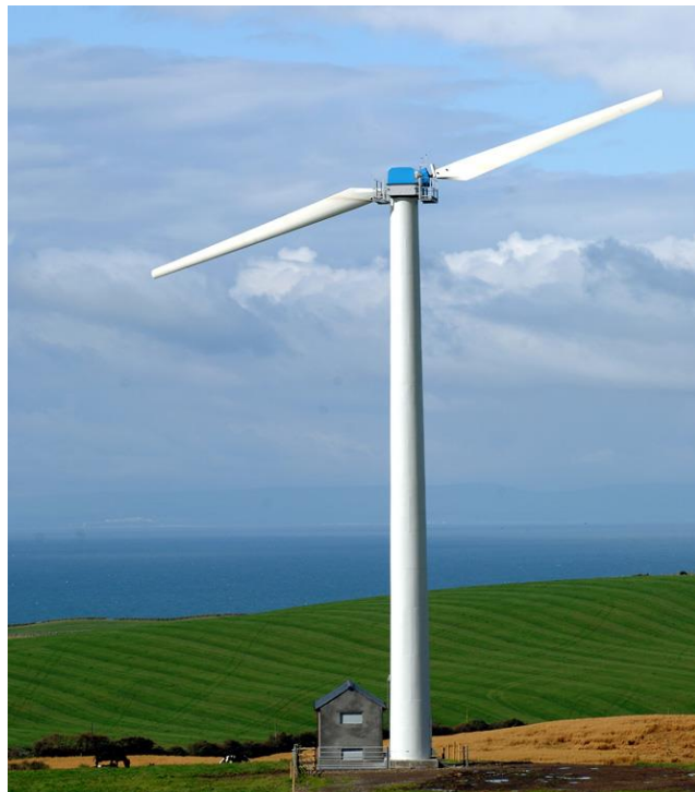
Figura 14. Turbina eólica com duas pás ( www.windenergysolutions.nl . Acesso em: 2 de maio 2015)
