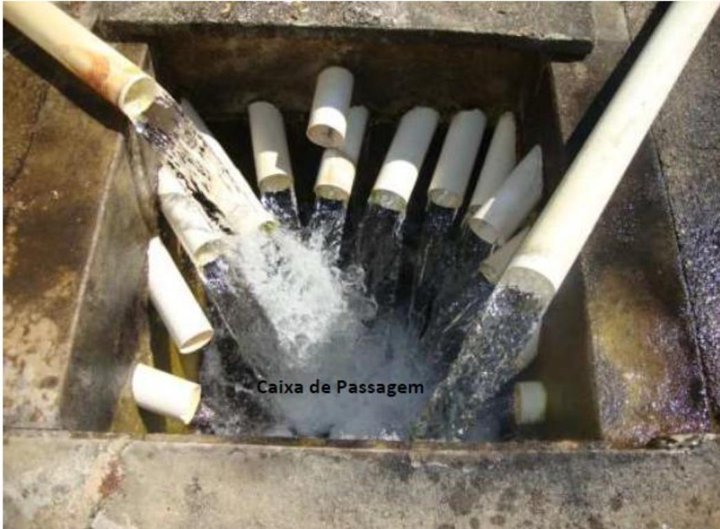
Figura 11. Caixa de passagem no interior da área cercada da captação. Toda água das fontes, Gênesis 1 e 2.
