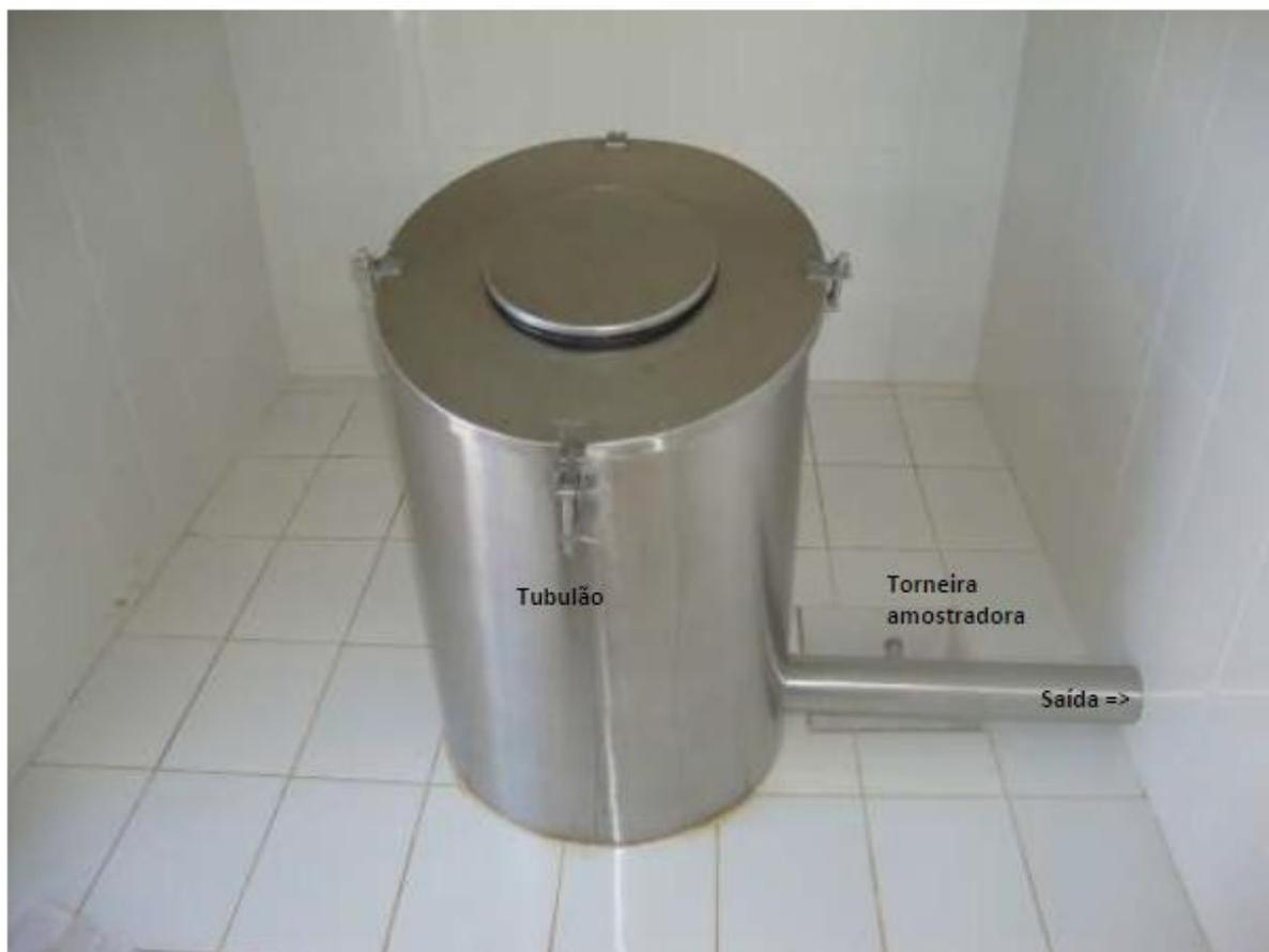
Figura 10. Tubulão instalado na captação denominada Fonte Gênesis 1. A fonte Gênesis 2 possui um tubulão idêntico.
