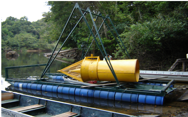
Figura 8 – Montagem para instalação da turbina hidrocínética com flutuantes. Fonte: (Campos, 2015).
