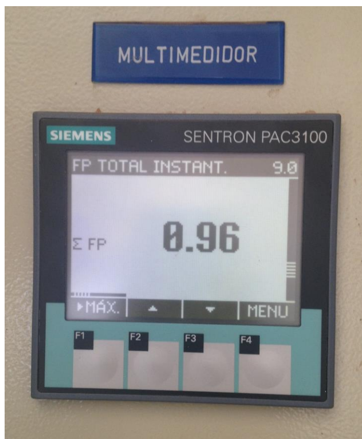
Figura 12. Multimetro SETRON PAC 3100.
